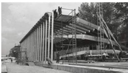
Fig. 11 Montaje de la estructura [20]
