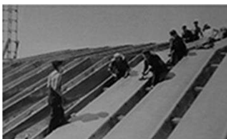
Fig. 13 Montaje de la cubierta [22]
